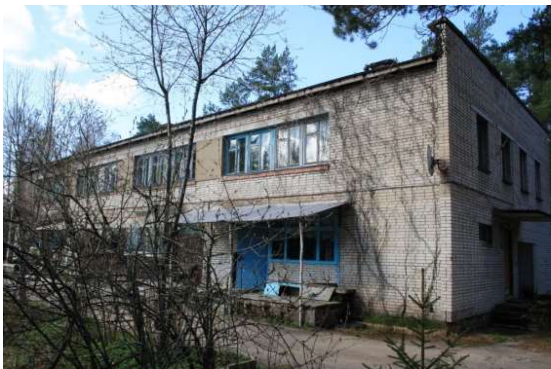
Фото №2. Дом №3. Фасад
