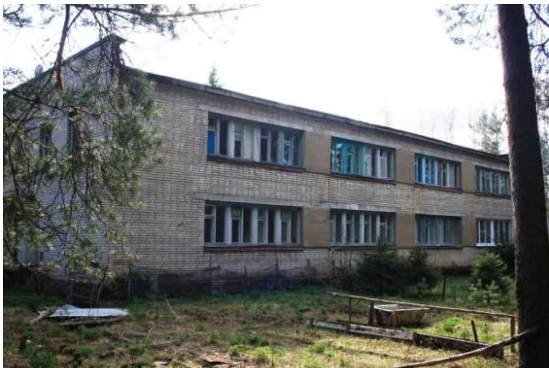
Фото №1. Дом №3. Фасад
