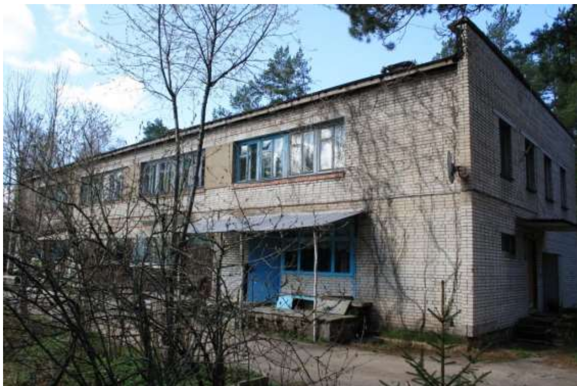
Фото №2. Дом №3. Фасад
