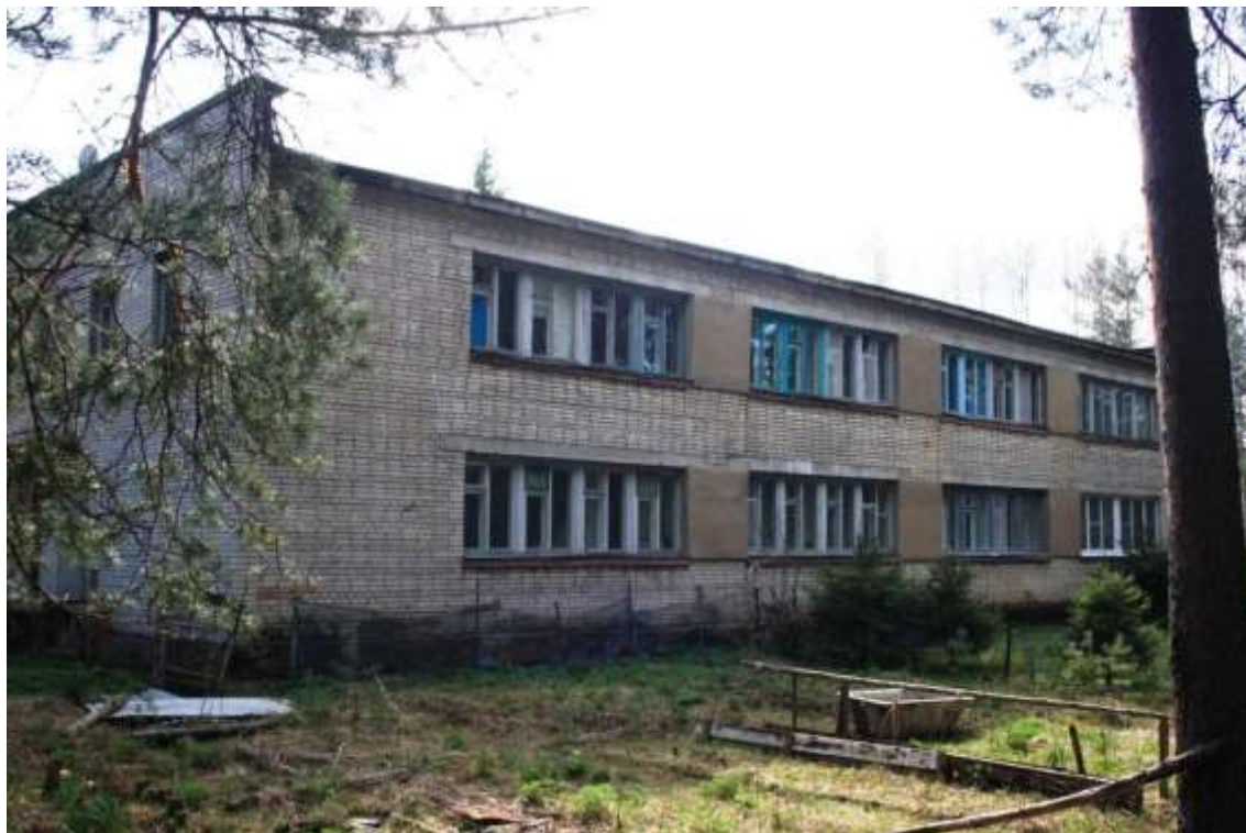
Фото №1. Дом №3. Фасад
